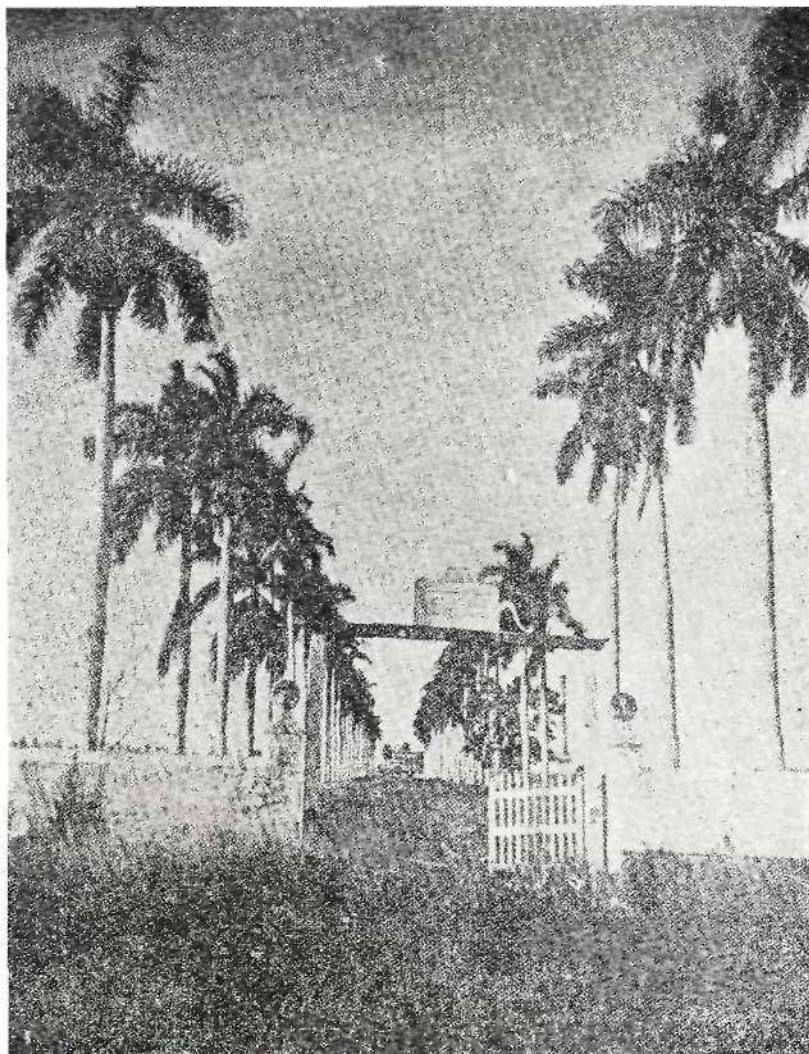
Entrada al ingenio Mi Rosa , en Quivicán, donde se atrincheró la columna del general Aldecoa en el encuentro con Máximo Gómez.
